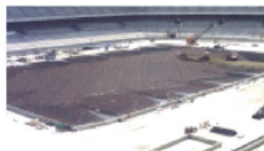
●配管施工時と竣工状況
